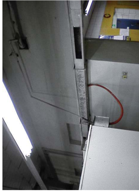
Зурагт 5-2-6: Үйлдвэрлэлийн эцсийн дамжлагын цехийн дулаан баригч хийгдээгүй хавхлага болон ХООЛОЙНУУД
