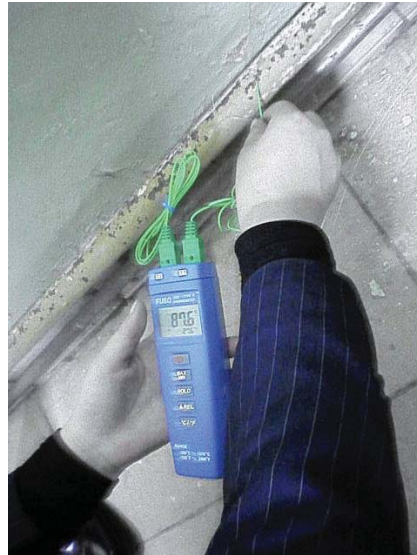
Зураг 4-1-8: Температур хэмжигчээр Хэмжилт хийж буй байдал
