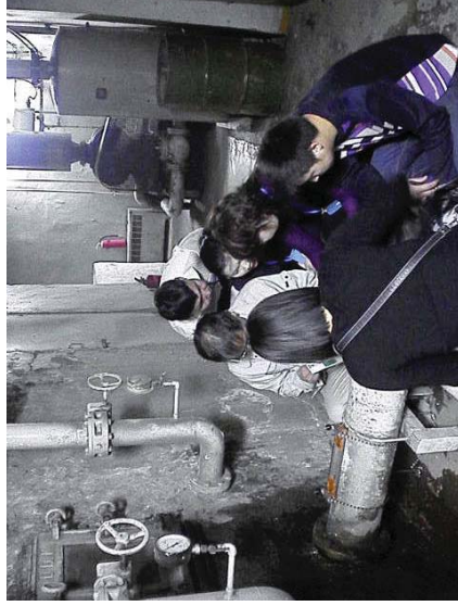
Зураг 4-1-9: Хэт авианы долгионоор урсгалтыг хэмжигчийг хэрэглэх талаарх зааварчилгаа.
