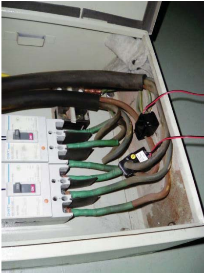
4-1-3: Slamp Цахилгаан гүйдлийн сенсорыг суурилуулсан байдал.
