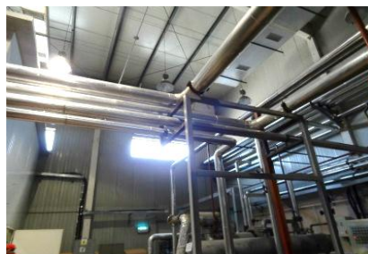
Узелийн өрөөнд байгалийн гэрлийг ашиглаж, цахилгаан гэрлийг унтраах
